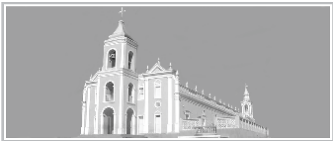
Igreja Matriz Nossa Senhora da Conceição, construída em 1885, por Cônego Pequeno
