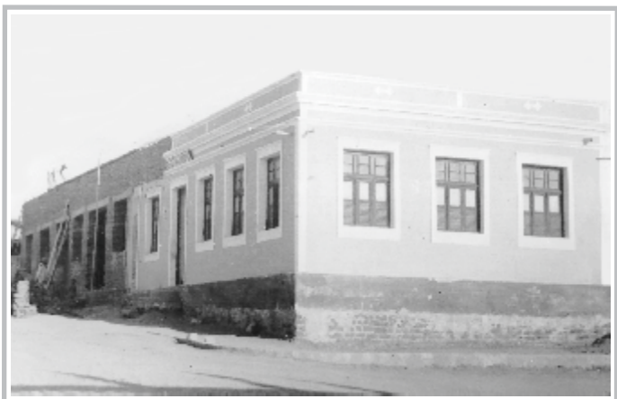
1954 - Construção da Prefeitura Municipal de Pocinhos, uma das primeiras obras realizadas pelo prefeito José Alves
