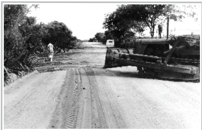
Alargamento da estrada que liga Pocinhos ao Km-21. Obra realizada no início da década de 1960 pelo prefeito José Alves.
